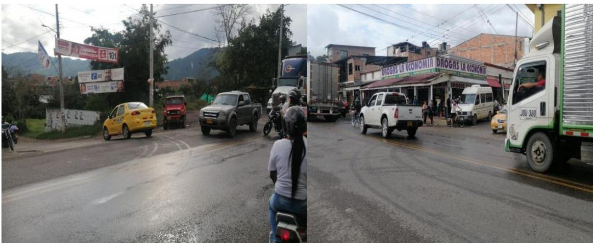
*Se carece de visibilidad con la que topa todo actor vial debido a la pendiente pronunciada que se evidencia en la imagen. Se sugiere la presencia de señales de tránsito verticales y reductores de velocidad.*
